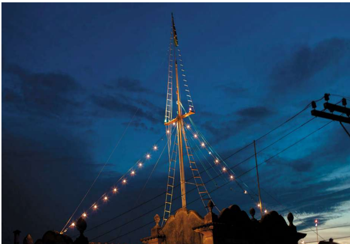
Mastarel instalado no telhado do Mercado do Porto do Sal.
